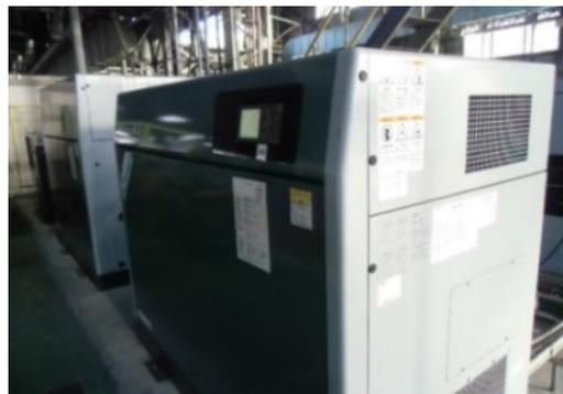
コンプレッサーの台数制御を実施しています。これにより、複数のコンプレッサーを消費空気量に応じ最小台数で効率的に稼働することが可能となり、省エネに貢献しています。
