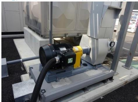
冷却水ポンプ用のメインモーターを、より省エネ効果の高い高効率モーターに転換および採用を進めています。更に、インバータ制御を組み合わせることで、より省エネ効果が期待できます。
