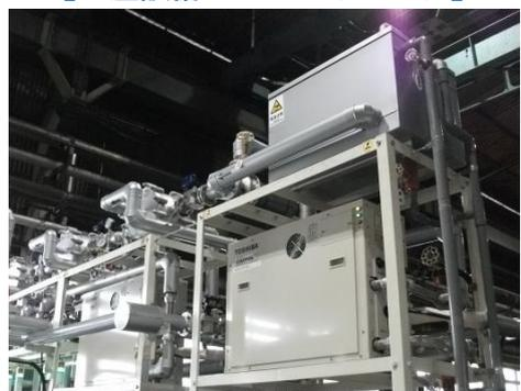
富士地区では全消費エネルギーの86%を電気が占めていました。中でも精密プレス部品の加工に使用する表面処理装置は電気ヒーターによる加温のため、多くの電気を消費しており、この加温方法を循環加温ヒートポンプとスパイラル熱交換機に切り替えることで、消費電力を約90%削減することができました。
