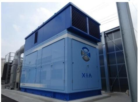
相模事業所では、都市ガスを燃料とした「コージェネレーションシステム」を導入しました。従来の重油炊きの温風ボイラーから切り替えることで、排熱回収を行うことができるようになり、約14%のエネルギー削減を実現することができました。
