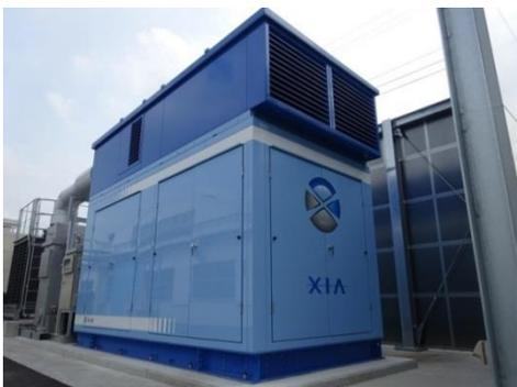
相模事業所では、都市ガスを燃料とした「コージェネレーションシステム」を導入しました。従来の重油炊きの温風ボイラーから切り替えることで、廃熱回収を行うことができるようになり、約14%のエネルギー削減を実現することができました。
