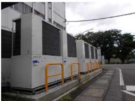
栃木工場（真岡）では、暖房に使用していたボイラーに替え都市ガスを使用したGHP（ガスヒートポンプ）を導入しました。GHPは廃熱回収を行う機器であり、従来であれば捨てていた廃熱を有効活用することによる省エネ効果が期待できます。
